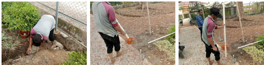
Gambar 22. Pembuatan instalasi pengairan SDG Durian pada Taman Agrostandar
